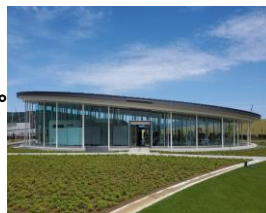
みやぎ 東日本大震災 津波伝承館
